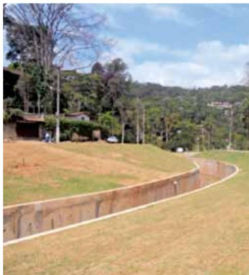
Em vários locais foram implantados muros de concreto pré-moldado
